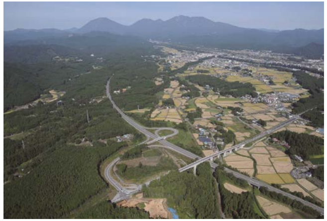
日光宇都宮道路と土沢インターチェンジ
