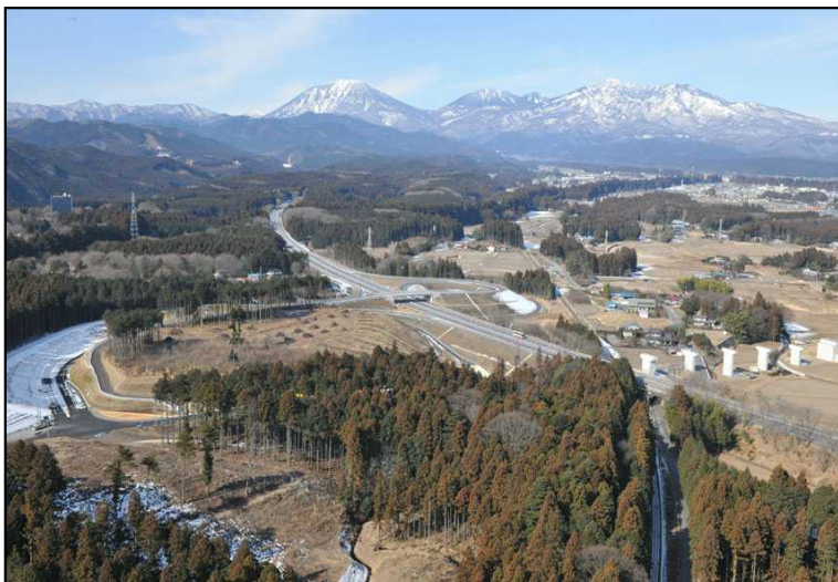
新たなインターチェンジの設置 (写真:土沢IC)
