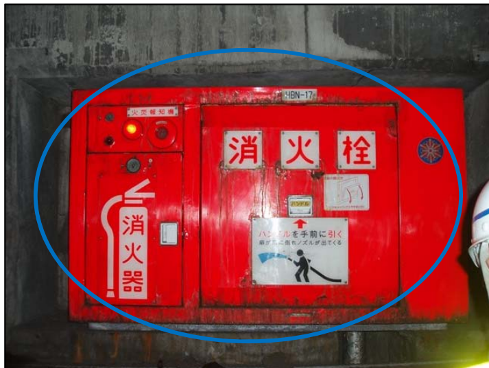
消火栓の発錆・腐食
