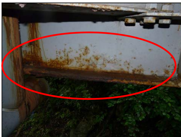
主桁・横桁の損傷
