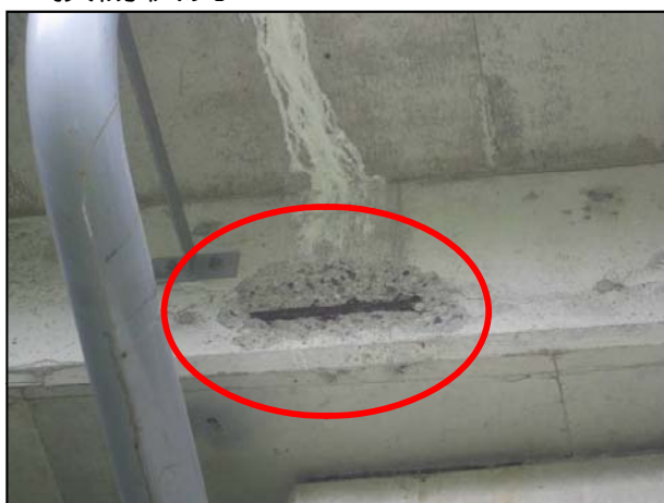
主桁の損傷
