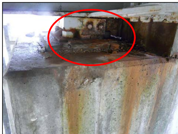
落橋防止・支承の損傷
