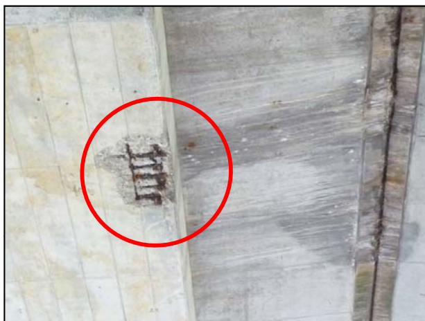
主桁の損傷
