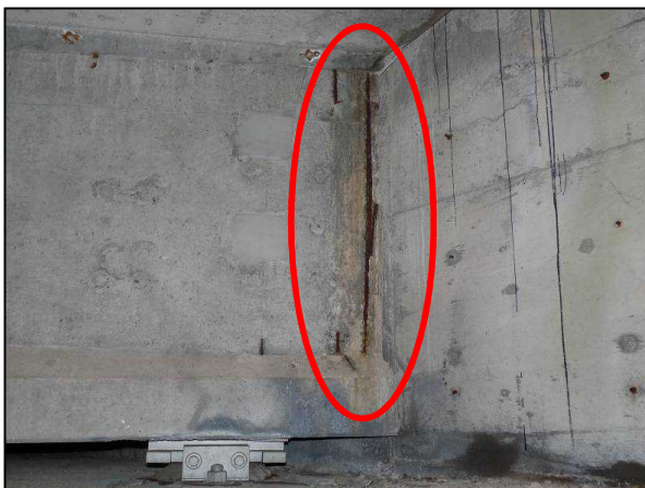
主桁の損傷
