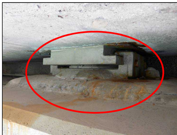
落橋防止・支承の損傷
