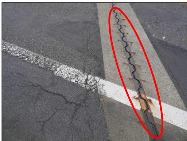
伸縮装置の損傷
