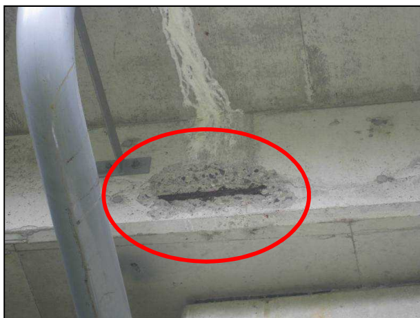
主桁の損傷
