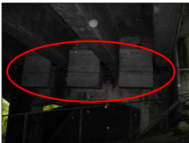
落橋防止装置の設置
