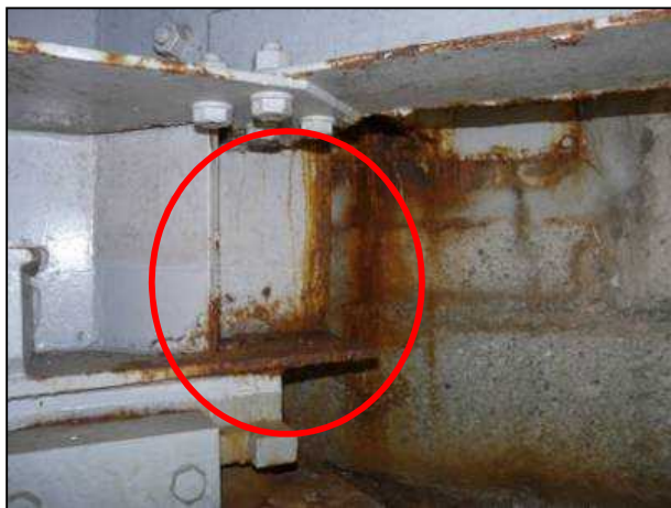
主桁の損傷
