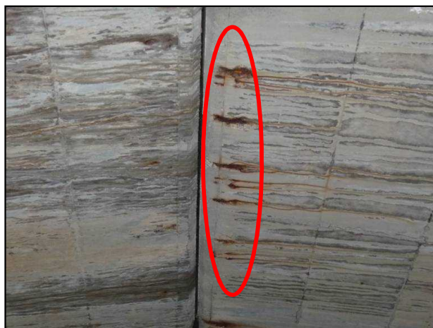
主桁・横桁の損傷
