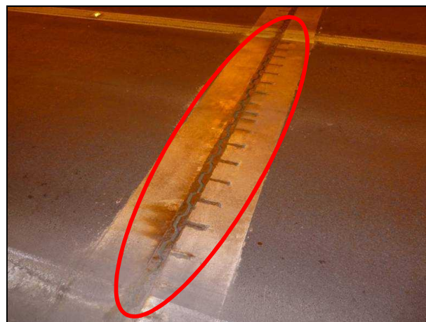
伸縮装置の損傷
