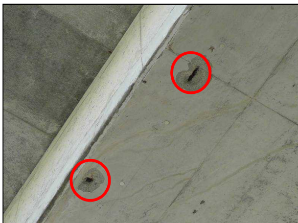
主桁の損傷
