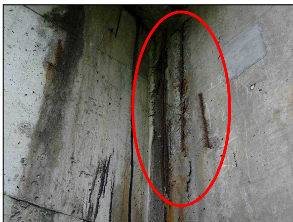
主桁の損傷
