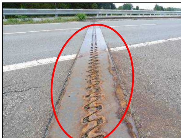
伸縮装置の損傷、漏水
