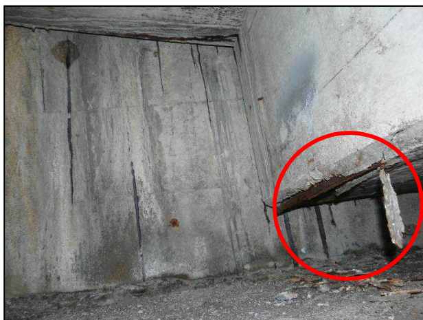
主桁の損傷
