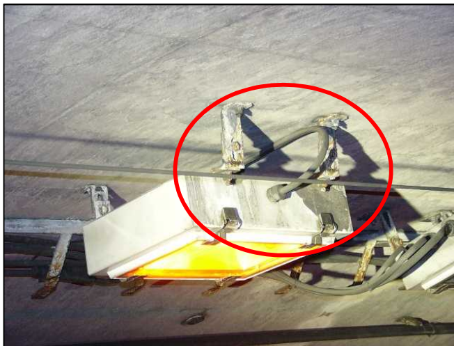
器具の塗装剥離、取付金具の発錆・腐食
