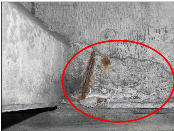
主桁・横桁の損傷
