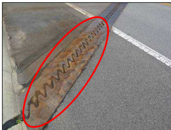
伸縮装置の損傷
