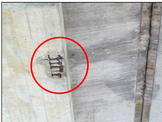
主桁の損傷
