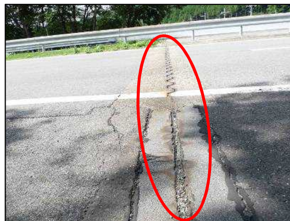
伸縮装置の腐食、漏水
