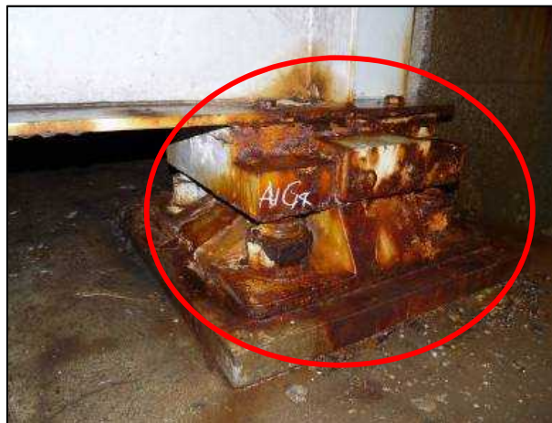
落橋防止・支承の損傷
