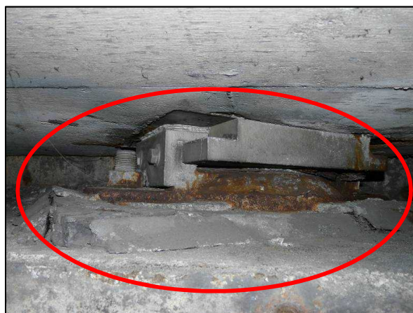
支承の腐食、沓座部剥離
