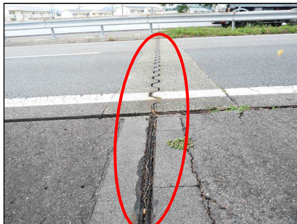
伸縮装置の腐食、漏水
