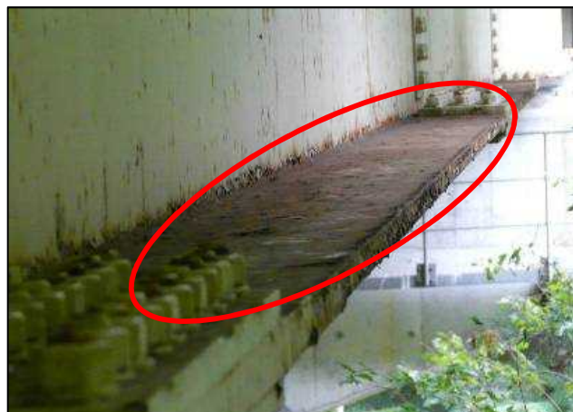
主桁・横桁の損傷
