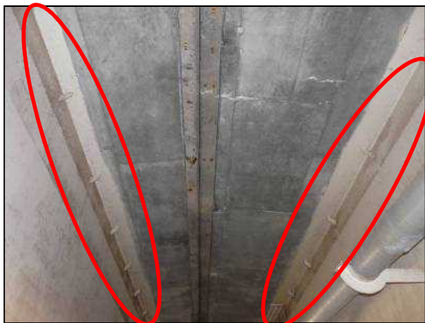
主桁・横桁の損傷
