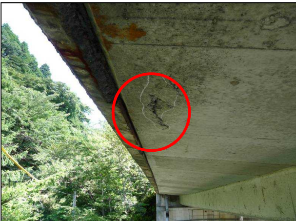
主桁の損傷
