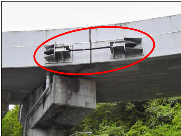
落橋防止装置の設置
