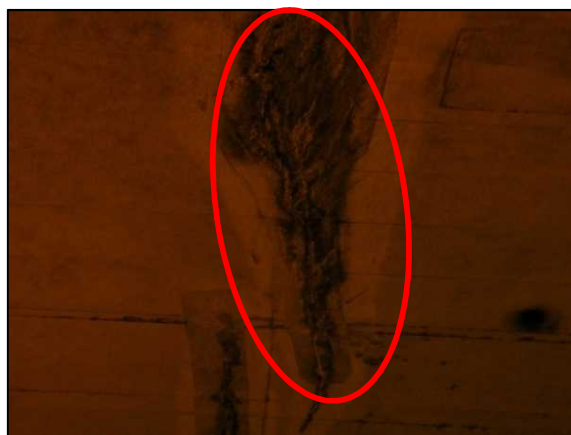
横断方向のひび割れ
