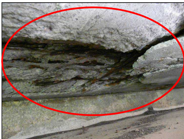
主桁・横桁の損傷
