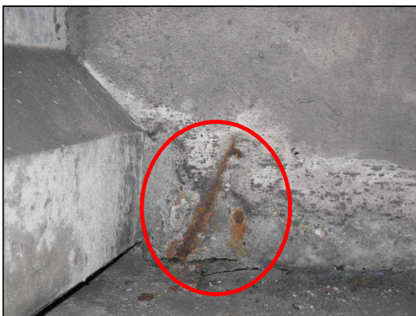
主桁・横桁の損傷
