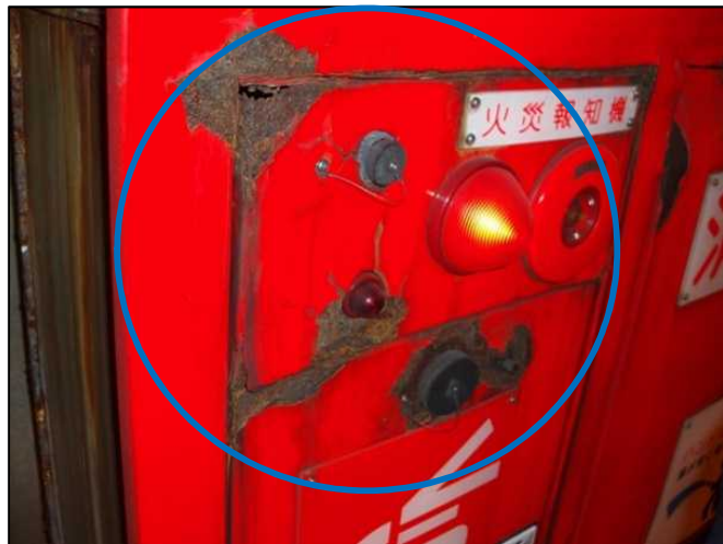
消火栓の発錆・腐食
