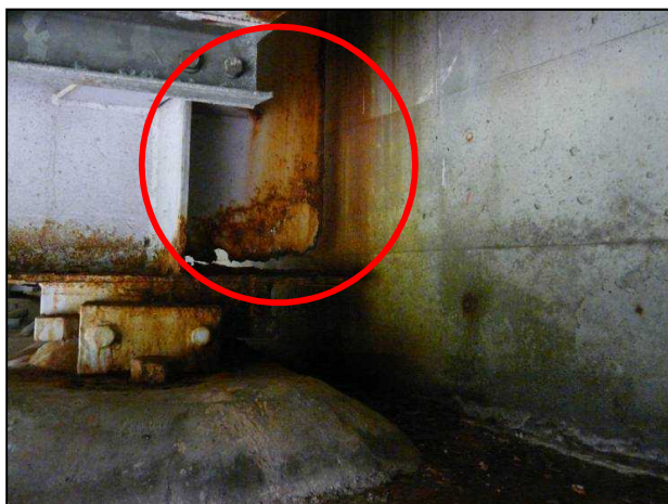
主桁の損傷
