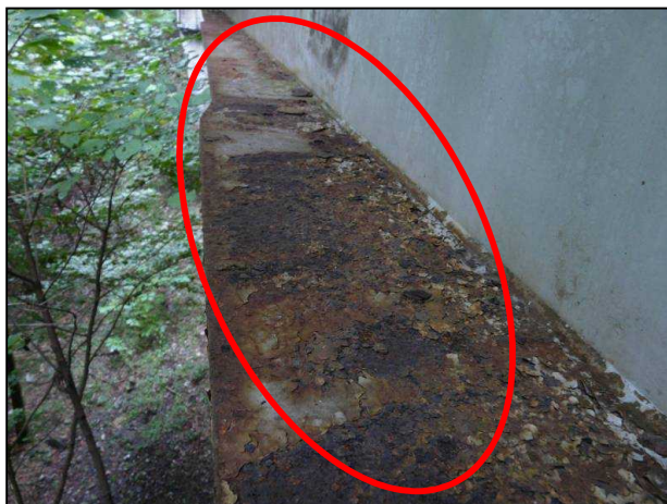
主桁・横桁の損傷
