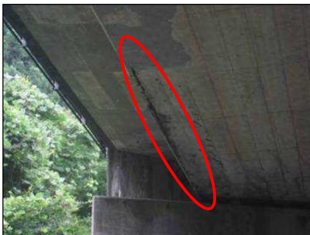
主桁の損傷
