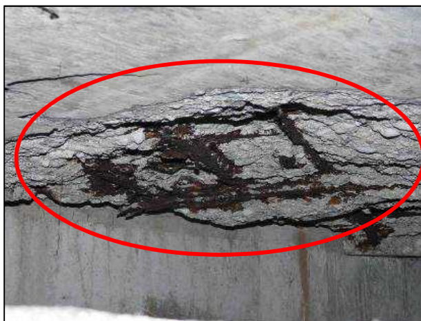
主桁の損傷
