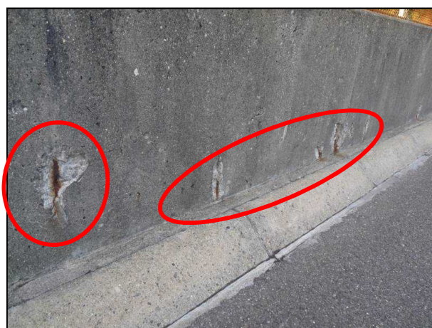
壁高欄の損傷
