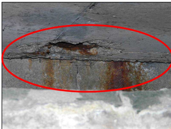
主桁の損傷
