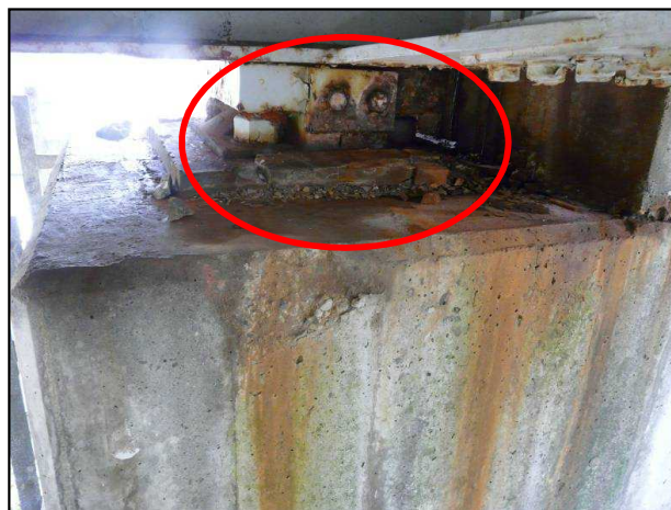
落橋防止・支承の損傷
