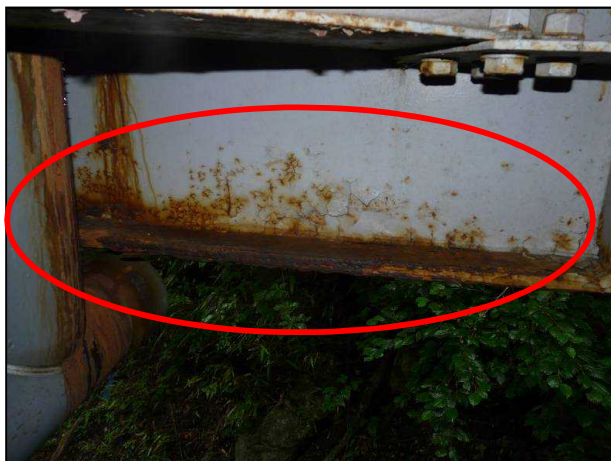
主桁・横桁の損傷
