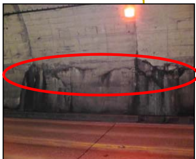
トンネル覆工損傷状況
