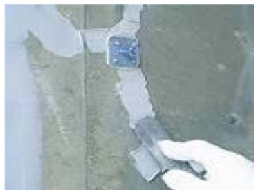
▲取付けパイプの接着とシーリング
