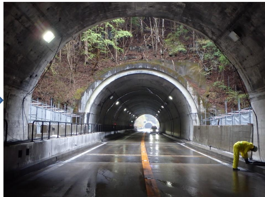
スノーシェルター撤去後
