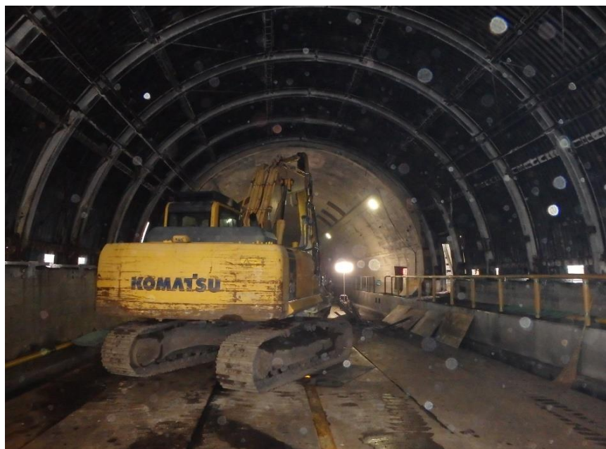
スノーシェルター撤去前
