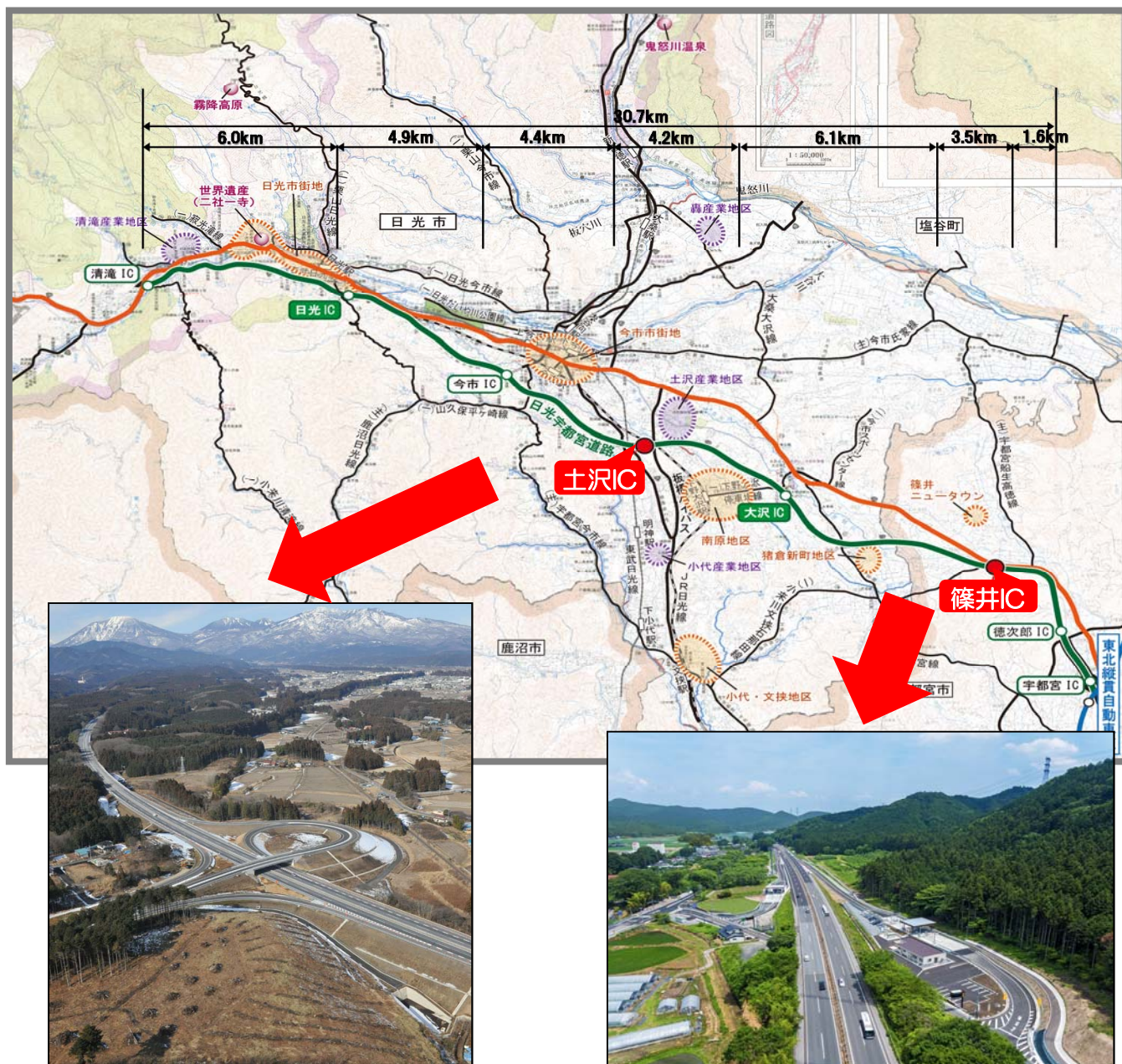
土沢インターチェンジ【平成23年3月撮影】
