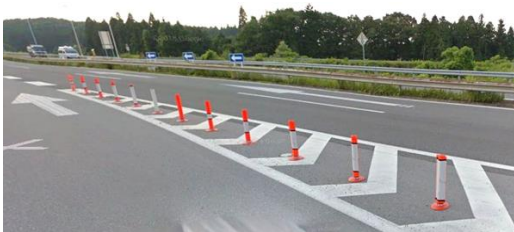
土沢ICの入口ランプ線（清滝方面）の本線合流部における、逆走防止のための青矢印、路面矢印、コーン設置
